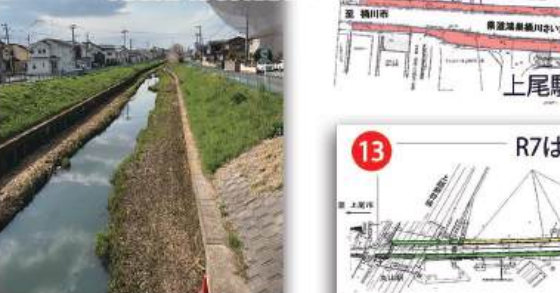
新井財橋～富士見橋区間 (さらに上下流域も 今後順次予算化検討)
